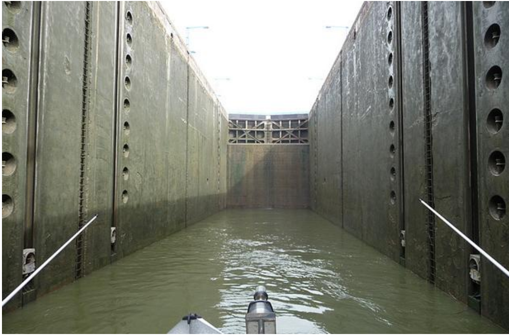
Figuur 28: foto van de schutkolk van de sluis van Les Fontinettes met een verval van 13,13 m
